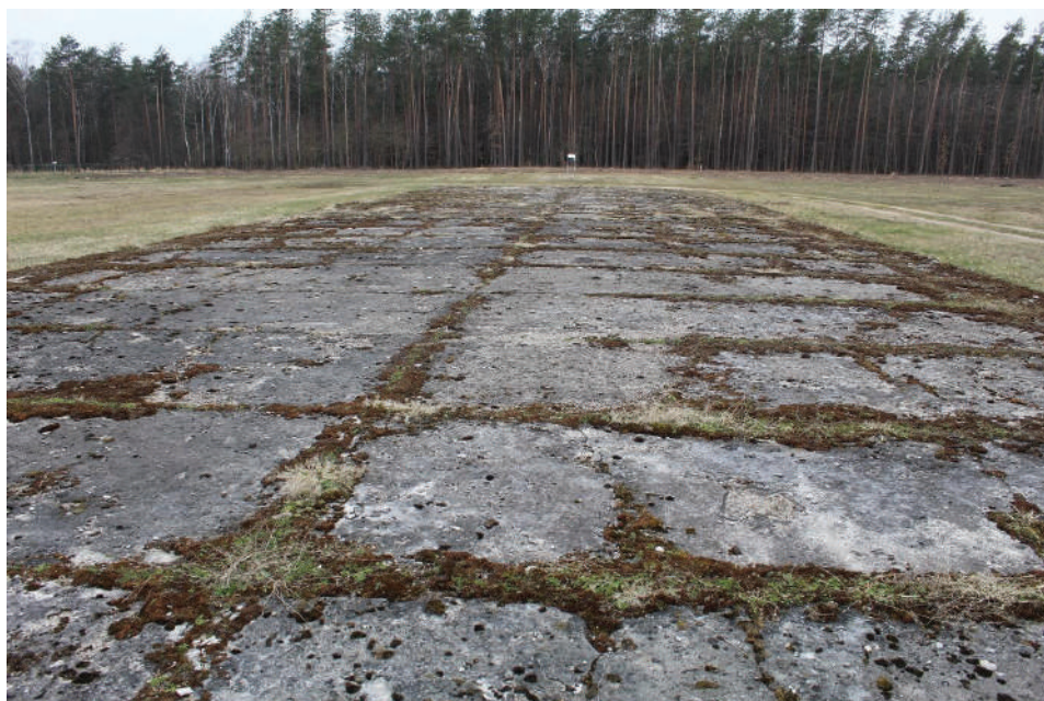
Zdjęcie 14. Magazyn (obiekt 17)
