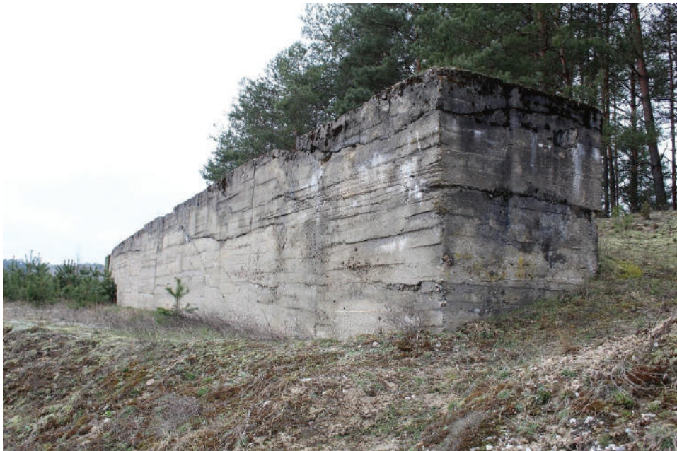
Zdjęcie 24. Rampa (obiekt 3)
