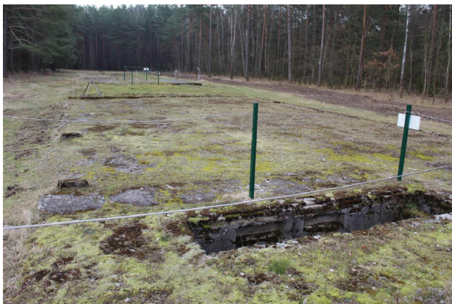
Zdjęcie 4. Garaż i warsztat samochodowy (obiekt 7)
