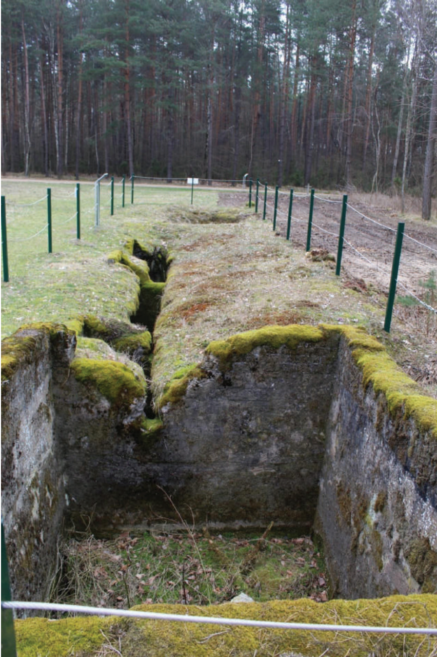
Zdjęcie 1. Szambo wielokomorowe (obiekt 23)
